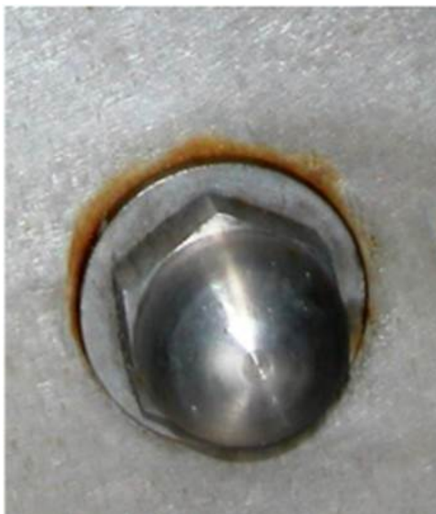
Slika 11. Korozija u procijepu između matice i podloške [16]
