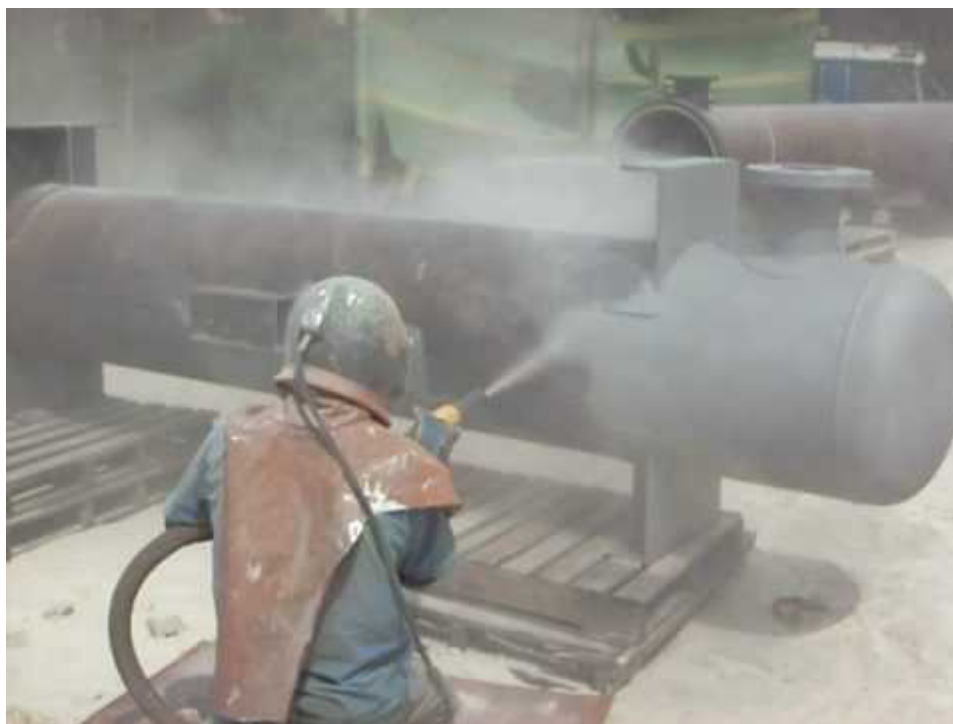
Slika 4. Postupak obrade mlazom [6]
