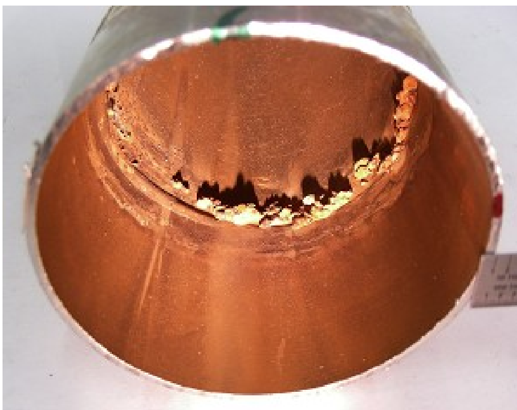
Slika 14. Mikrobiološki poticana korozija u području zavora na unutarnjoj stijenci cijevi od nehrđajućeg čelika [20]
