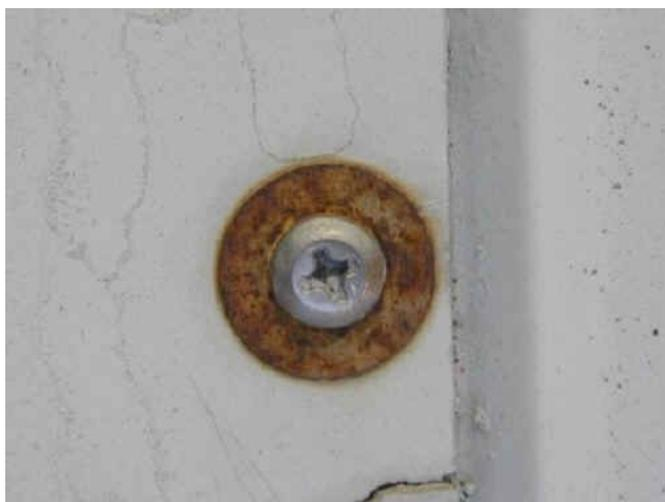
**Slika 9. Galvanska korozija nastala zbog razlike potencijala između vijka i podloške [14]**
