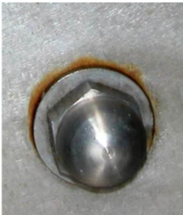
**Slika 11. Korozija u procijepu između matice i podloške [16]**
