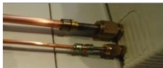
Slika 23 Spajanje cijev s „Lok-ring“ spojnica [4]
