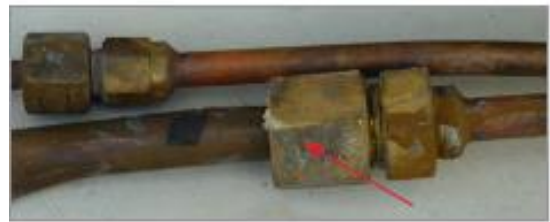
Slika 21 Uklanjanje mehaničkih spojeva cijevi lemljenjem [4]
