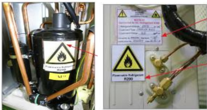
Slika 34 Označavanje vanjske jedinice [4]
