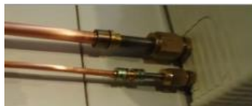
Slika 23 Spajanje cijev s „Lok-ring“ spojnica [4]
