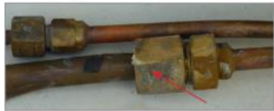
Slika 21 Uklanjanje mehaničkih spojeva cijevi lemljenjem [4]
