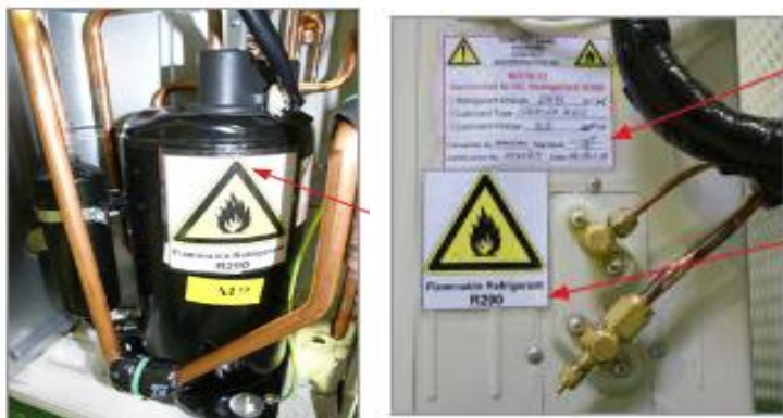
Slika 34 Označavanje vanjske jedinice [4]
