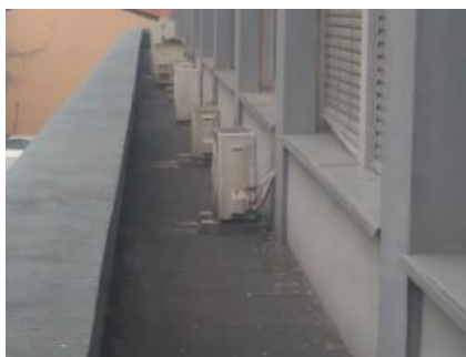
Slika 17 Vanjska jedinica
