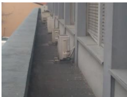
Slika 17 Vanjska jedinica
