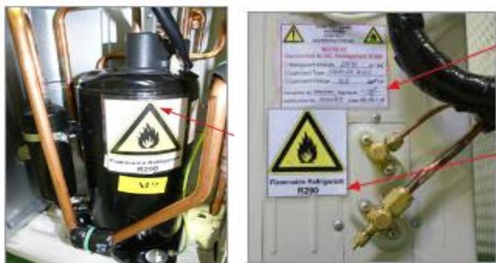
Slika 34 Označavanje vanjske jedinice [4]
