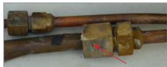
**Slika 21** Uklanjanje mehaničkih spojeva cijevi lemljenjem [4]
