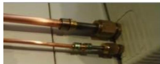
**Slika 23** Spajanje cijevi s „Lok-ring“ spojnicama [4]
