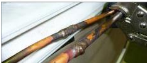
Slika 20 Mehanički spoj u zoni boravka [4]
