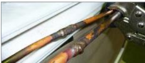
Slika 20 Mehanički spoj u zoni boravka [4]
