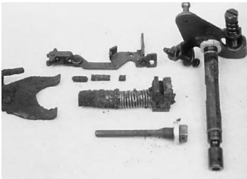
Slika 3. Elementi oštećeni zbog hrđe u vodi
