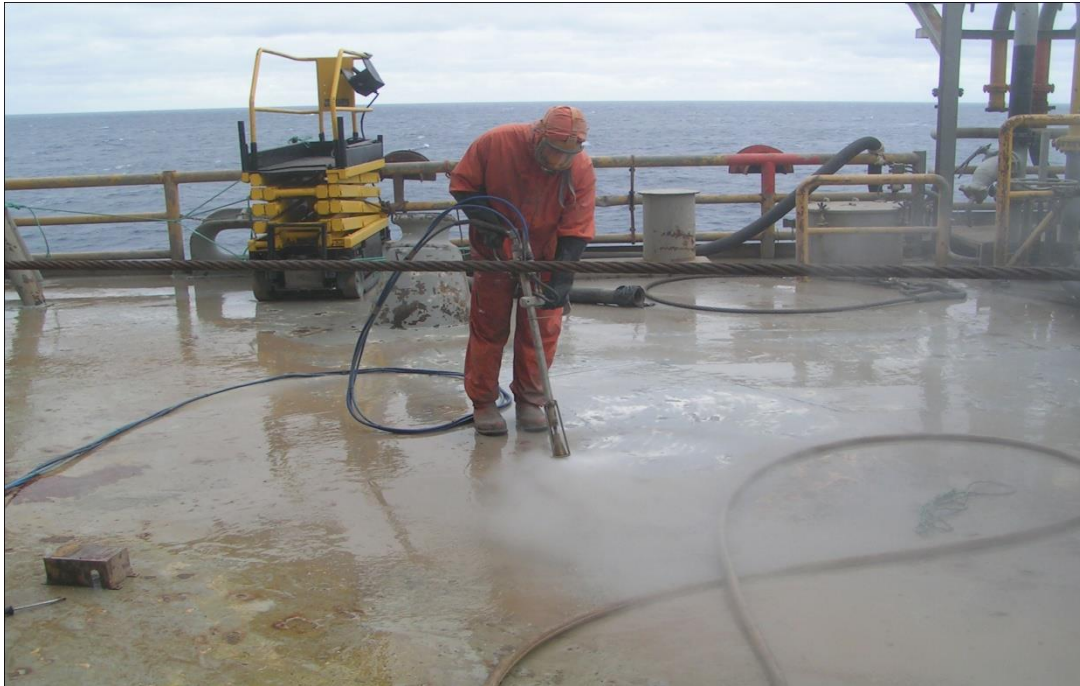
Slika 8. Čišćenje vodenim mlazom [11]
