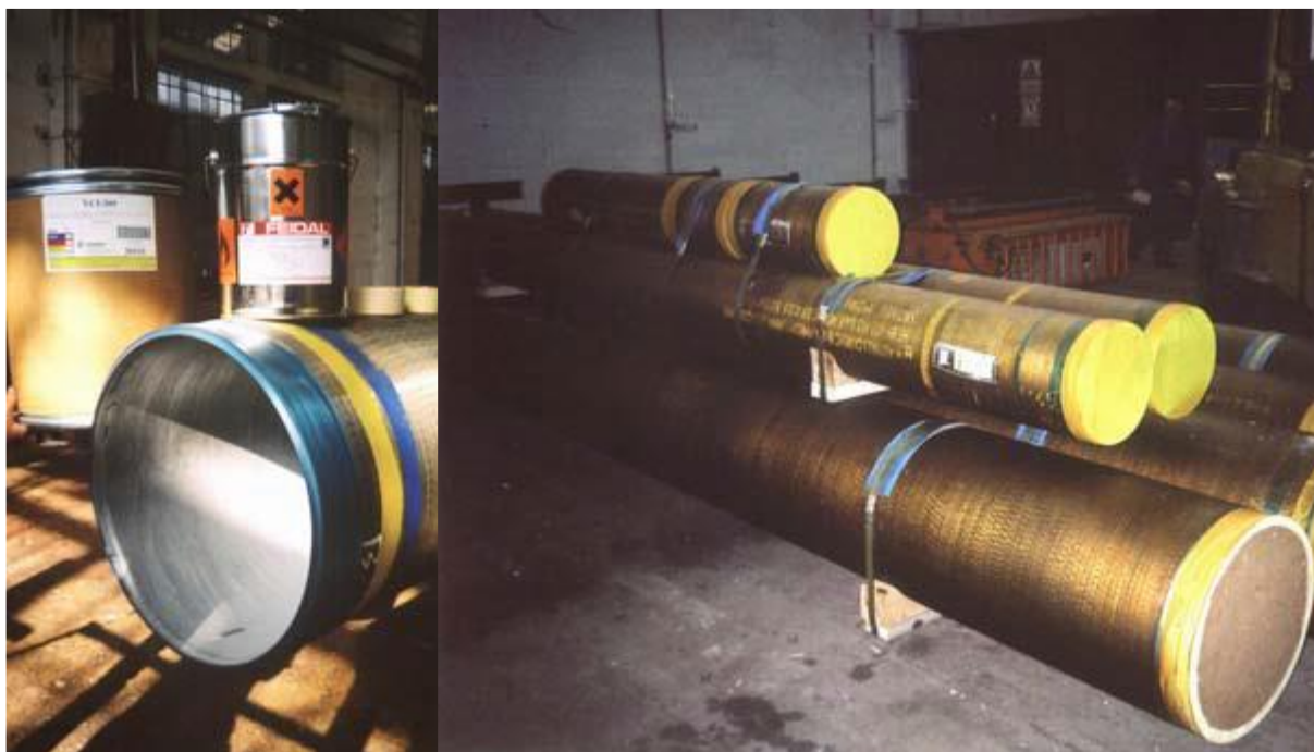
Slika 9. Zaštita unutrašnjosti cijevi inhibitorom korozije [20]
