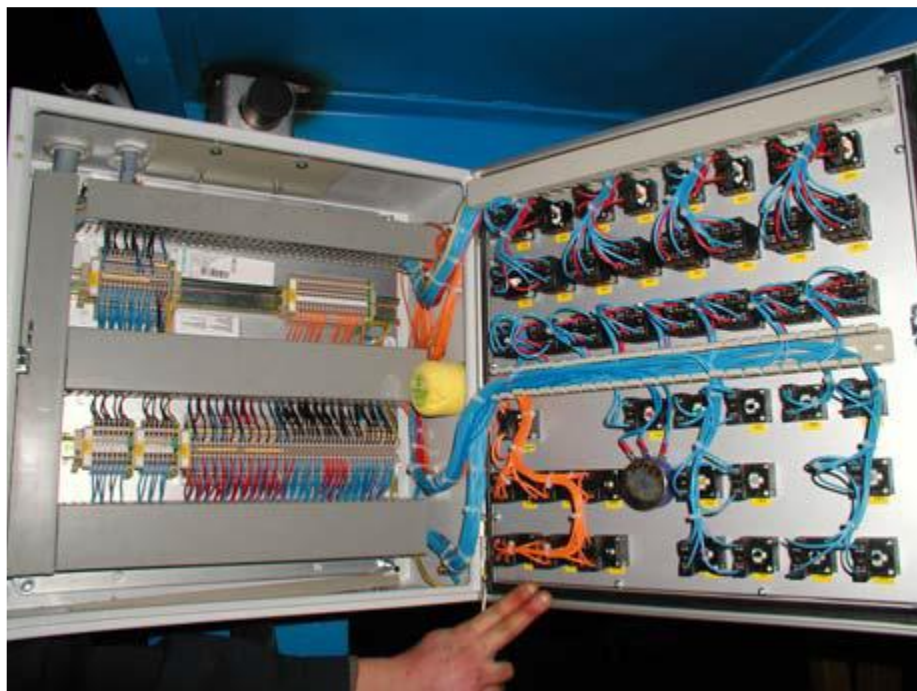
Slika 10. Primjena inhibitora za zaštitu električkih sklopova u upravljačkom ormariću [20]
