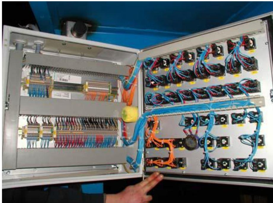
Slika 10. Primjena inhibitora za zaštitu električkih sklopova u upravljačkom ormariću
