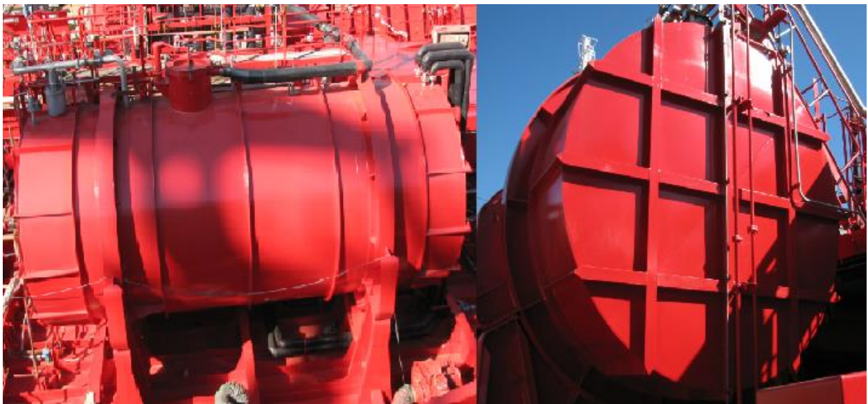
Slika 13. Spremnik od nehrđajućeg čelika dodatno zaštićen organskim premazima
