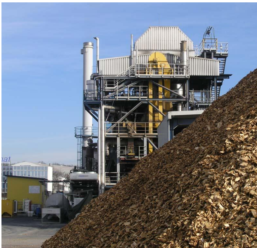
Slika 1. Postrojenje za rasplinjavanje koje koristi drvene sječke [1]
