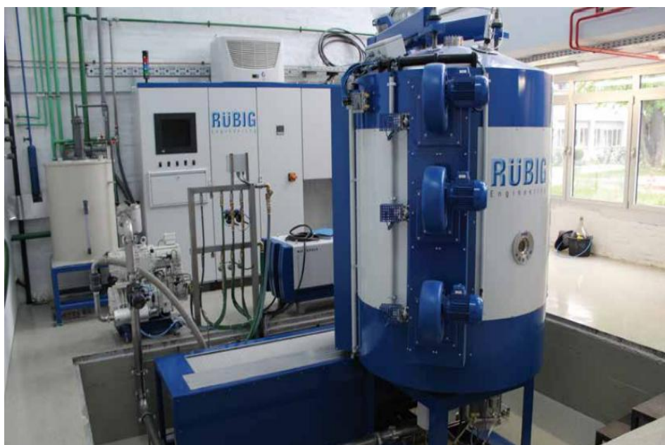
Slika 3.2. PACVD uređaj tvrtke RÜBIG instaliran na Fakultetu strojarstva i brodogradnje [8]
