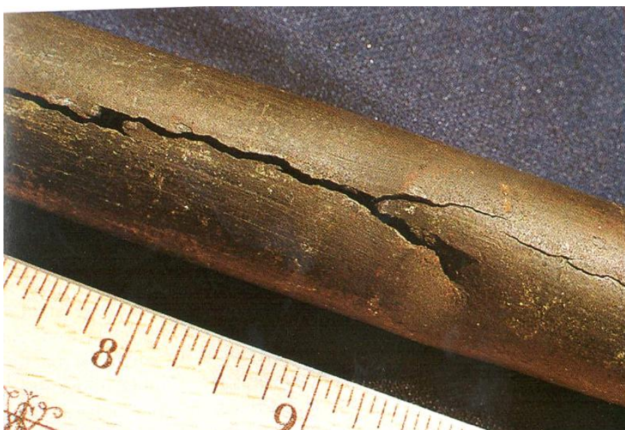
Slika 12. Pukotina uzrokovana napetosnom korozijom [13]
