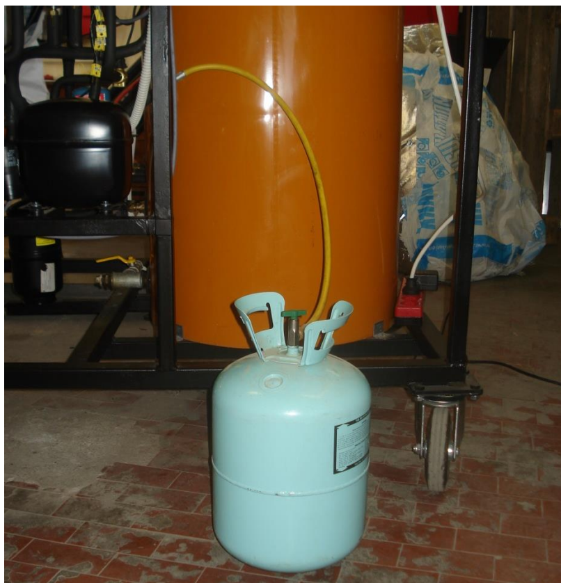
Slika 11 Punjenje sustava s radnom tvari
