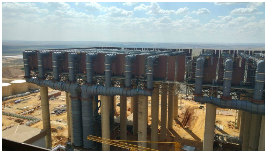
Slika 48. Pogled na kondenzator u izgradnji [7]
