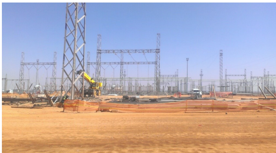
Slika 45. Dalekovod u izgradnji [6]
