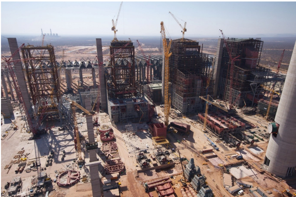
Slika 37. Generatori pare elektrane Medupi u izgradnji [7]
