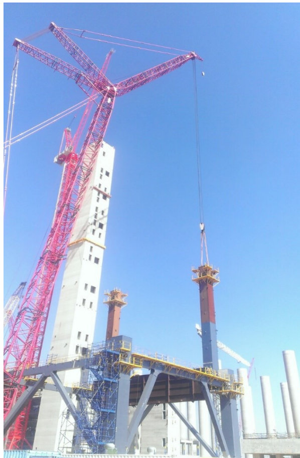
Slika 51. Dizalica za izgradnju generatora pare visine 140 m
