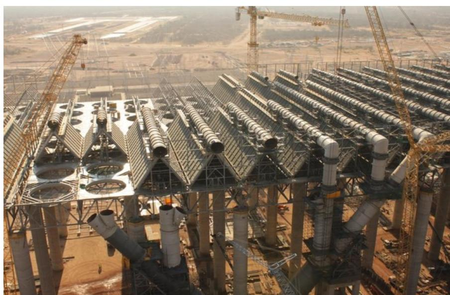
Slika 49. Prikaz izmjenjivačkih površina kondenzatora
