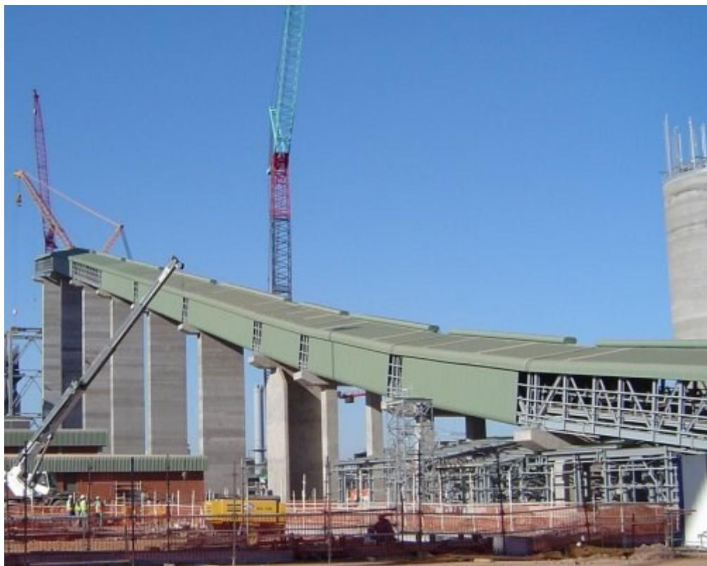
**Slika 39.** Konstrukcija za dovoz ugljena do kotla [21]
