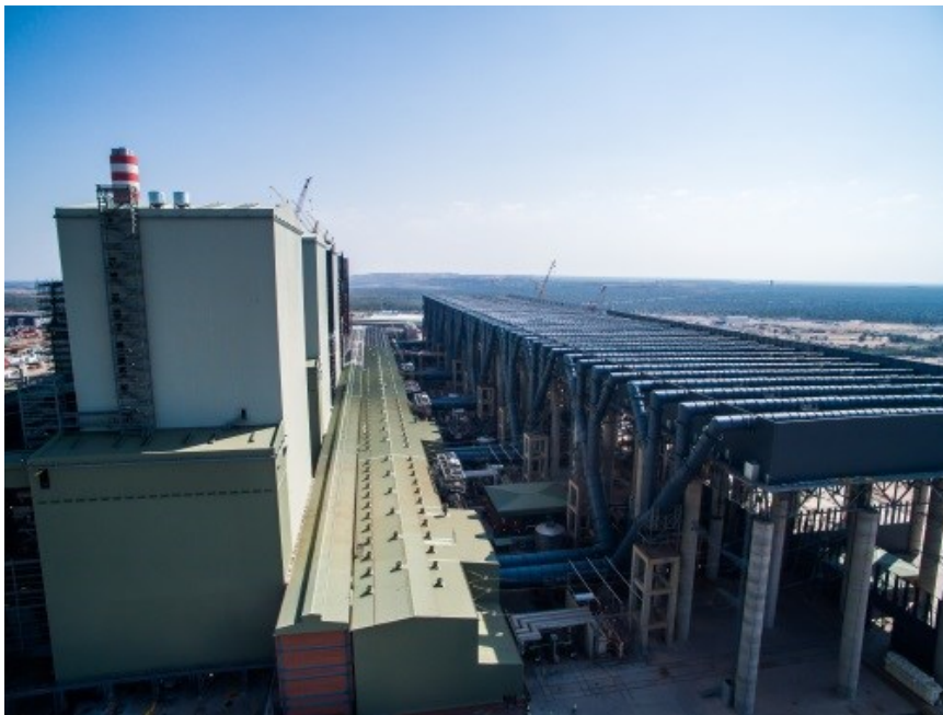
Slika 50. Spoj niskotlačnog dijela turbine i kondenzatora [6]
