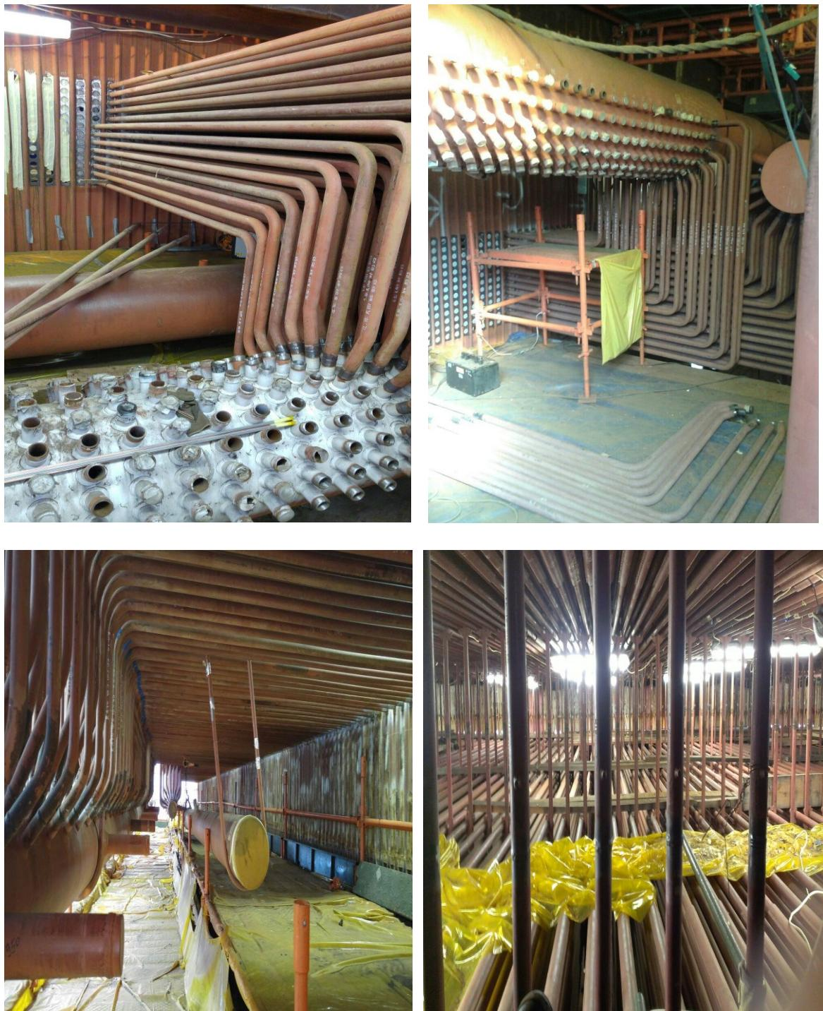
**Slika 38.** Izmjenjivačke površine i cijevi generatora pare
