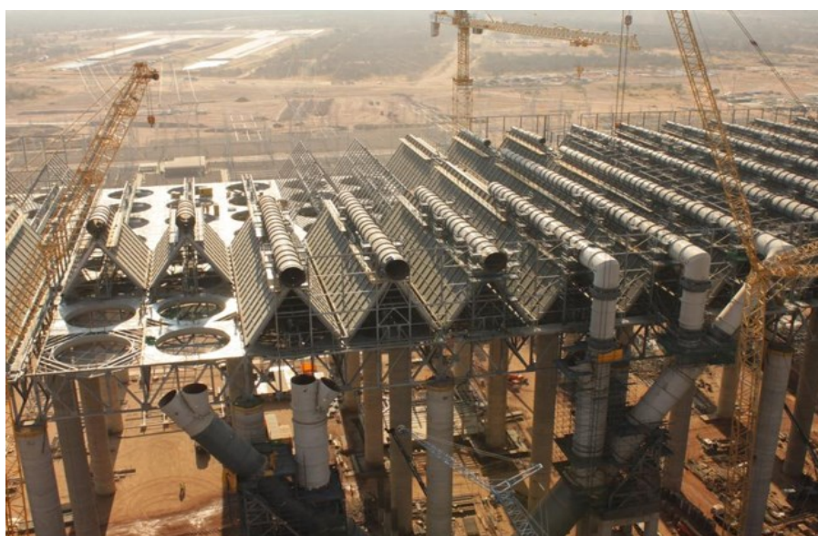
Slika 49. Prikaz izmjenjivačkih površina kondenzatora
