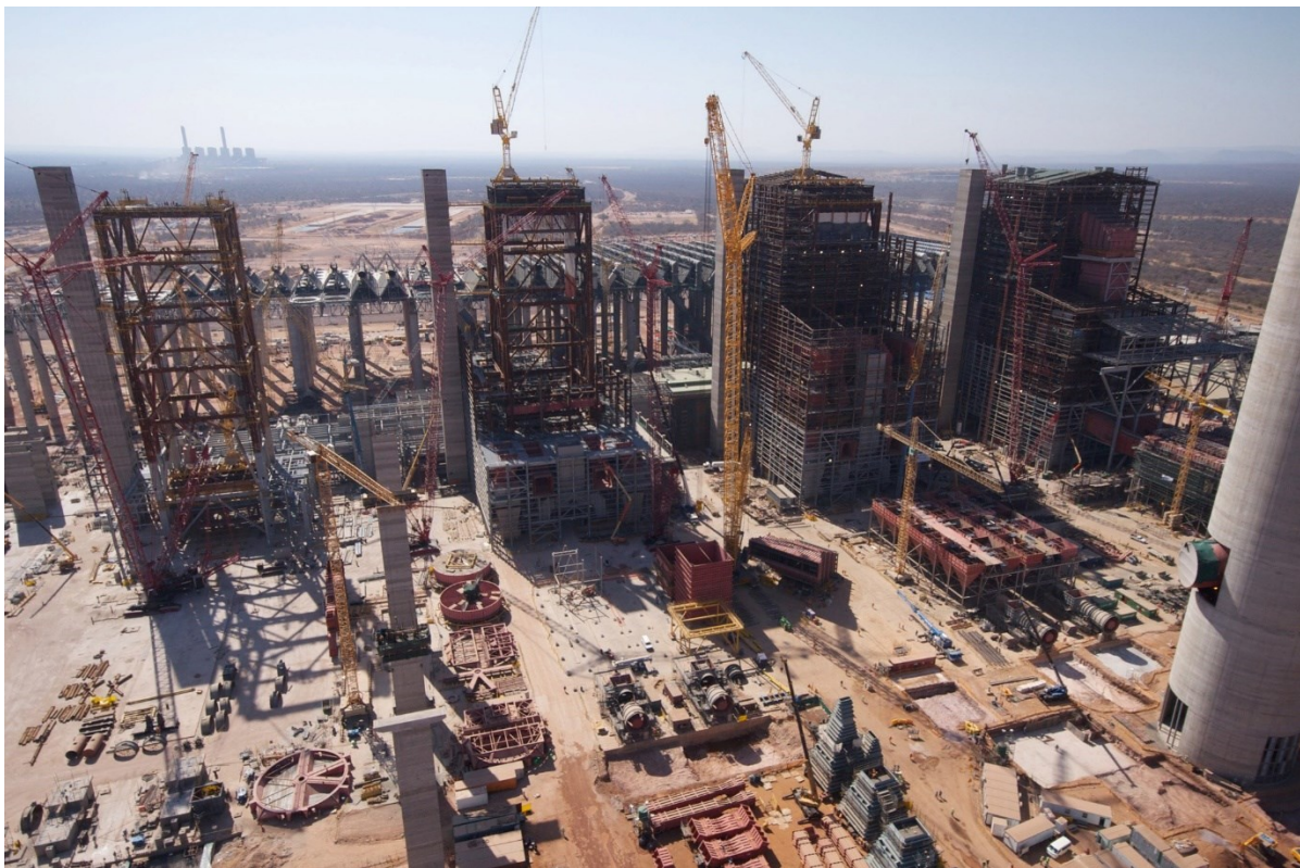
Slika 37. Generatori pare elektrane Medupi u izgradnji [7]
