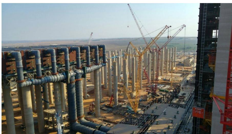
Slika 46. Nosiva konstrukcija kondenzatora
