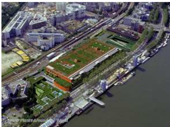
Slika 11. WtE Postrojenje Isséane (Pariz, Francuska)
