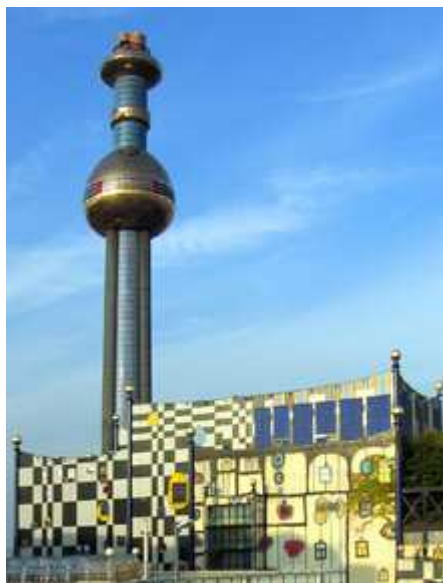
Slika 9. Spalionica otpada Spittelau (Beč, Austrija)
