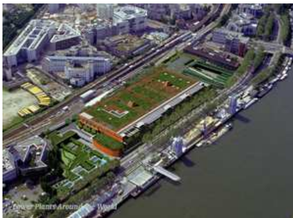
Slika 11. WtE Postrojenje Isséane (Pariz, Francuska)
