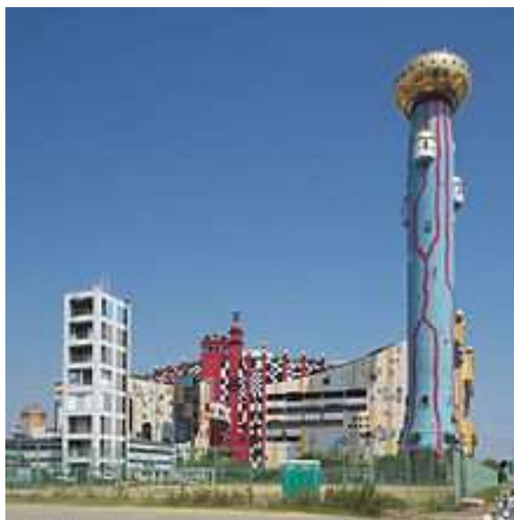
Slika 10. Spalionica otpada Maishima (Osaka, Japan)
