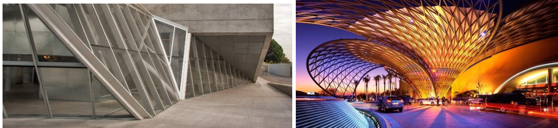
Slika 13. Kontinuirana staklena pročelja
