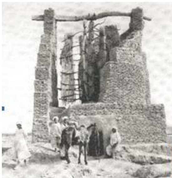
Slika 2. Mlin na vjetar s područja Afganistana i Irana- 7. stoljeće [2]
