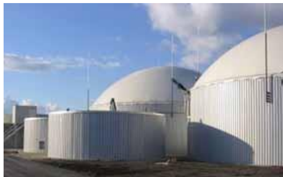
Slika 15. Vertikalni fermentatori pokriveni membranom koja ne propušta plin.
