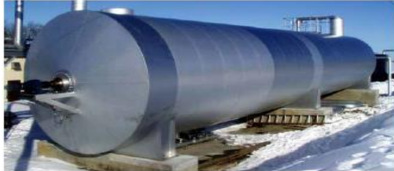
Slika 16. Horizontalni digestor.
