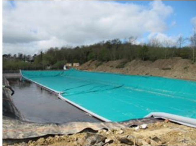
Slika 60. PVC pokrov spremnika digestata.
