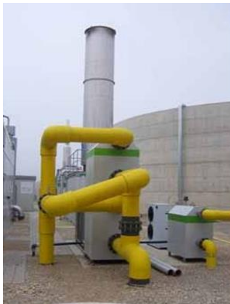
Slika 19. Moderna baklja za bioplin.
