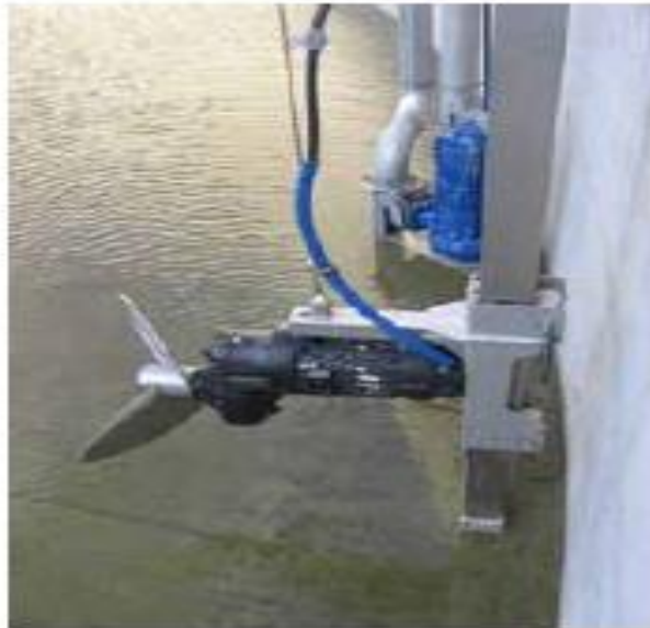
Slika 17. Motorna mehanička elisna mješalica sa mogućnosti potapljanja.
