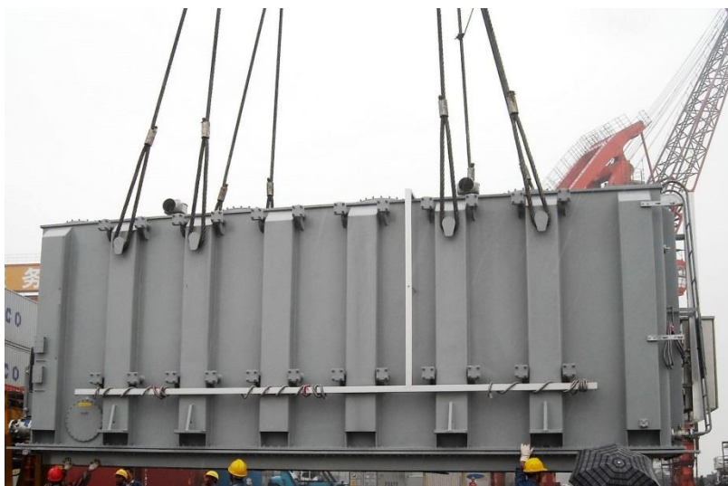
Slika 10. Primjer dizanja velikog energetskog transformatora
