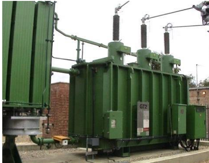
Slika 7. Primjer transformatora s pločastim zavjesnim elementima
