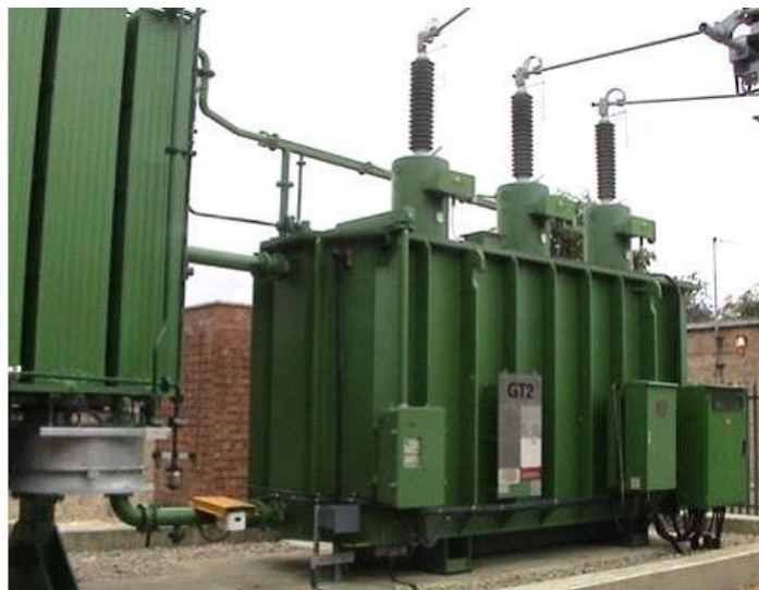
Slika 7. Primjer transformatora s pločastim zavjesnim elementima
