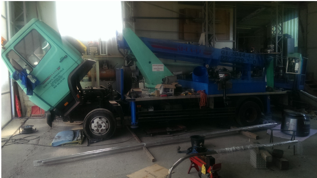
Slika 2. Radovi na radnoj platformi
