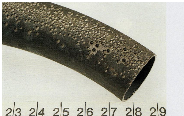
Slika 13. Rupičasta korozija na titanu i titanovim legurama [6]
