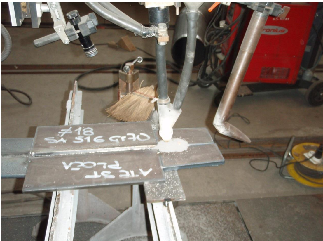
Slika 45. Uspostava električnog luka kod EPP zavarivanja [29]
