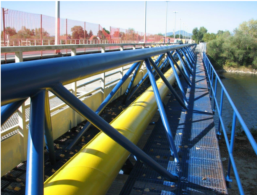
Slika 28. Primjena epoksidnog premaza na mostovima, Podsusedski most
