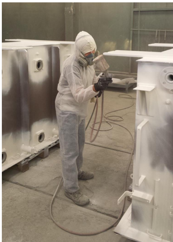
Slika 15. Nanošenje premaza zračnim prskanjem, Končar – Metalne konstrukcije d.d.
