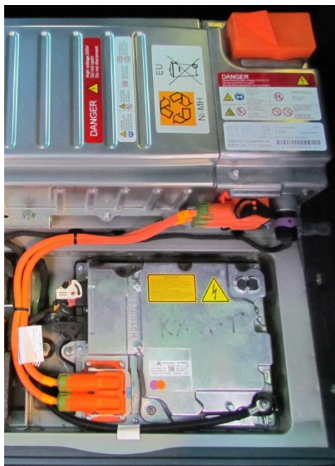
Slika 2.3 Kabeli visokog istosmjernog napona [3]
