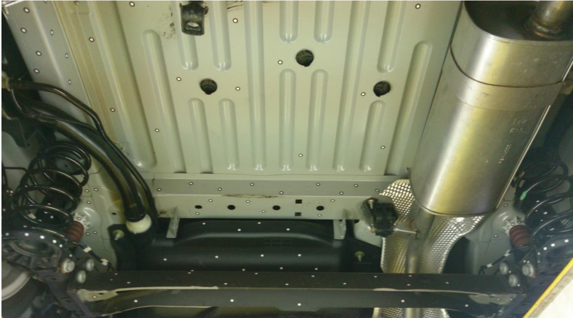
Slika 3.3 Prostor za ugradnju električnog pogona
