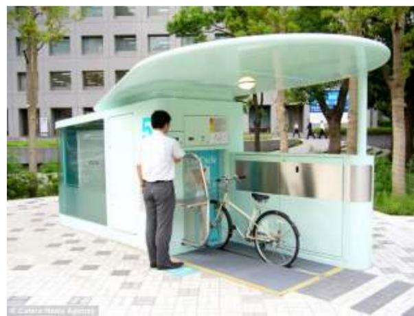
Slika 2.32. Princip pohranjivanja bicikla – „Eco Cycle“
