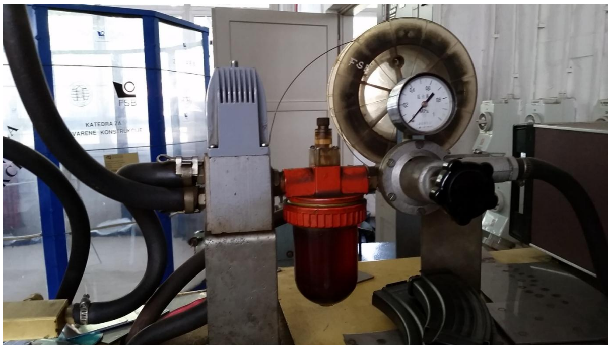
Slika 24. Manometar, nauljivač i elektromagnetski razvodnik
