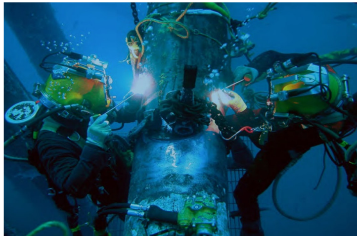
Slika 26. Popravak naftne platforme podvodnim zavarivanjem [25]
