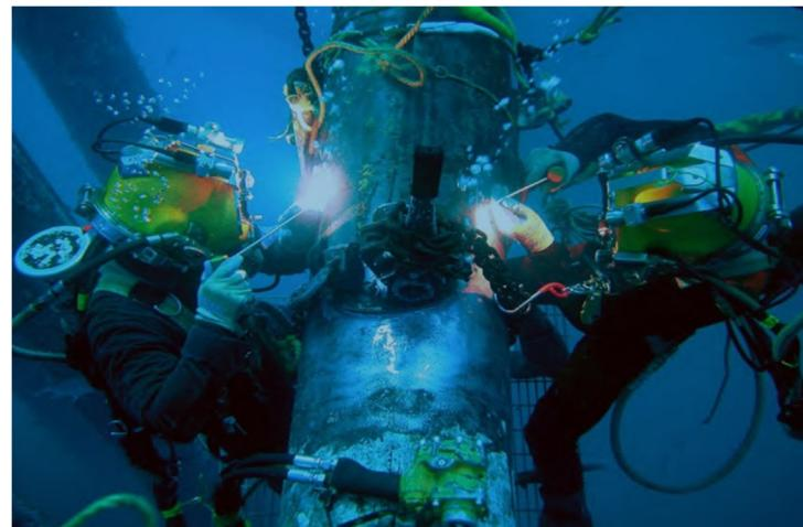
**Slika 26. Popravak naftne platforme podvodnim zavarivanjem [25]**
