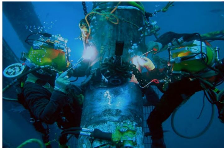
Slika 26. Popravak naftne platforme podvodnim zavarivanjem [25]
