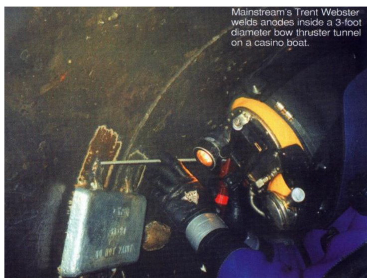
Slika 28. Izmjena cinkove anode [21]
