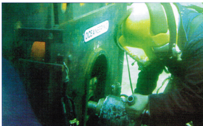
Slika 25. Podvodno zavarivanje trenjem [20]
