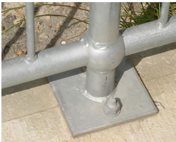
Slika 12. Primjer zavora na pocinčanoj ogradi [11]
