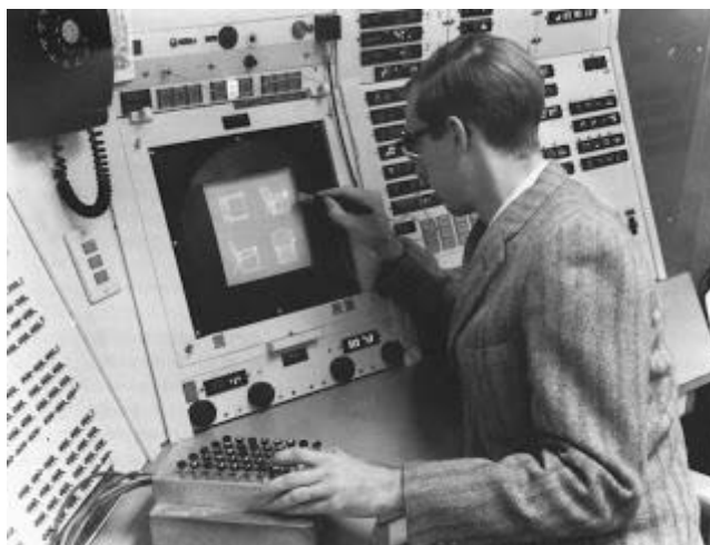
Slika 3 Sketchpad sustav na konzoli TX-2 u MIT-u(1963)[4]
