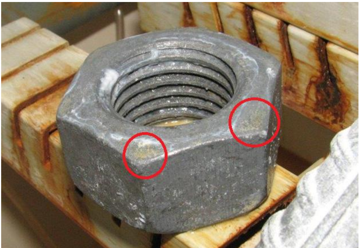
Slika 6.21. Žuti tragovi korozije na šerardiziranoj matici [22]
