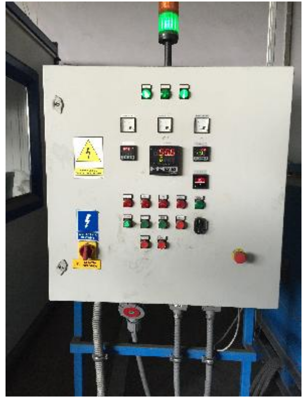
Slika 6.4. Upravljačka ploča peći za šerardiziranje [22]
