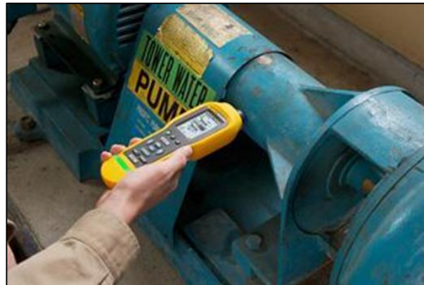
Slika 11. Ispitivanje vibracija [11]
