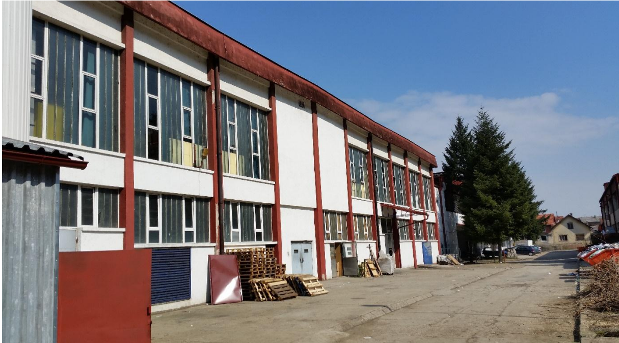
Slika 3.2. Jugoistočna strana objekta, pogled prema sjeveroistoku.
