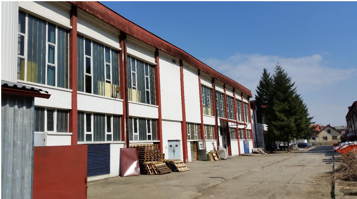
Slika 3.2. Jugoistočna strana objekta, pogled prema sjeveroistoku.
