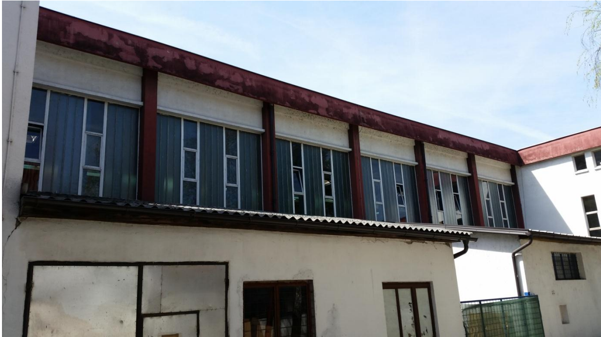
Slika 3.5. Sjeveroistočna strana objekta, pogled prema sjeverozapadu.
