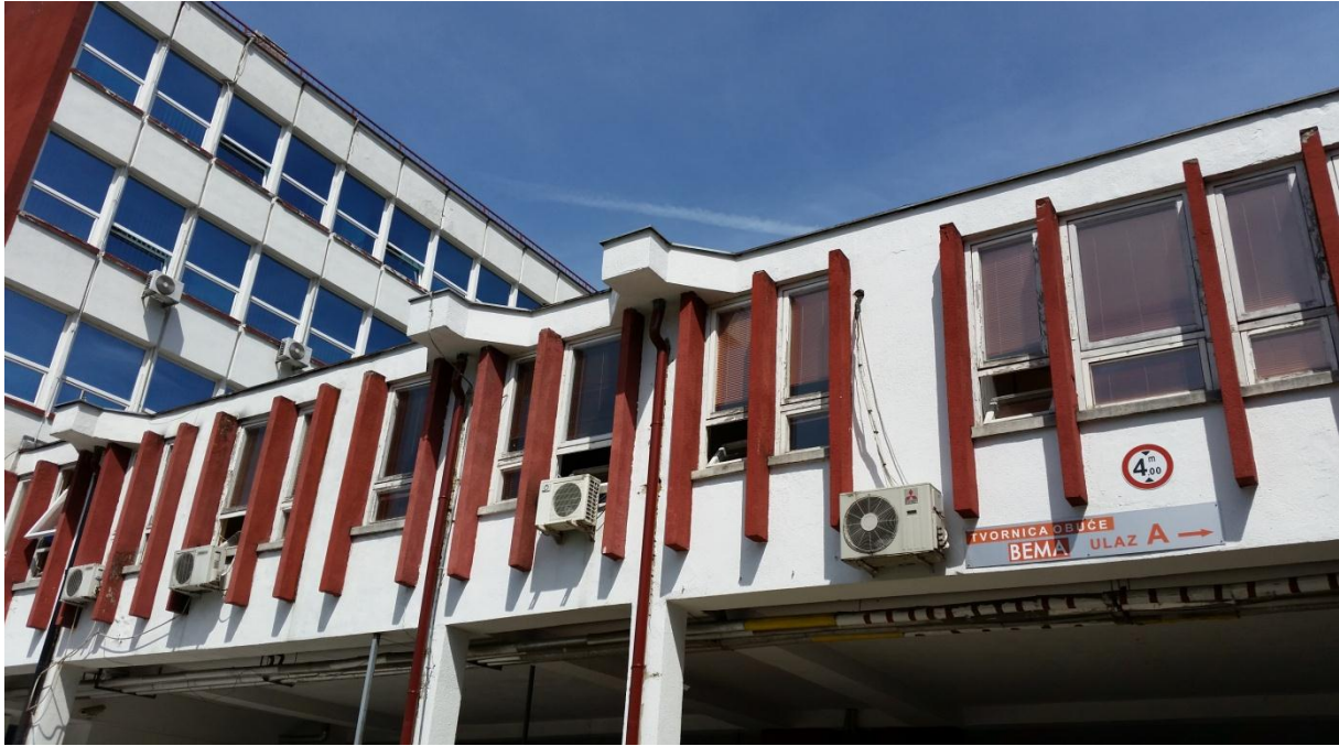
Slika 3.4. Spojni most s uredskim prostorima i klima – split sustavima
