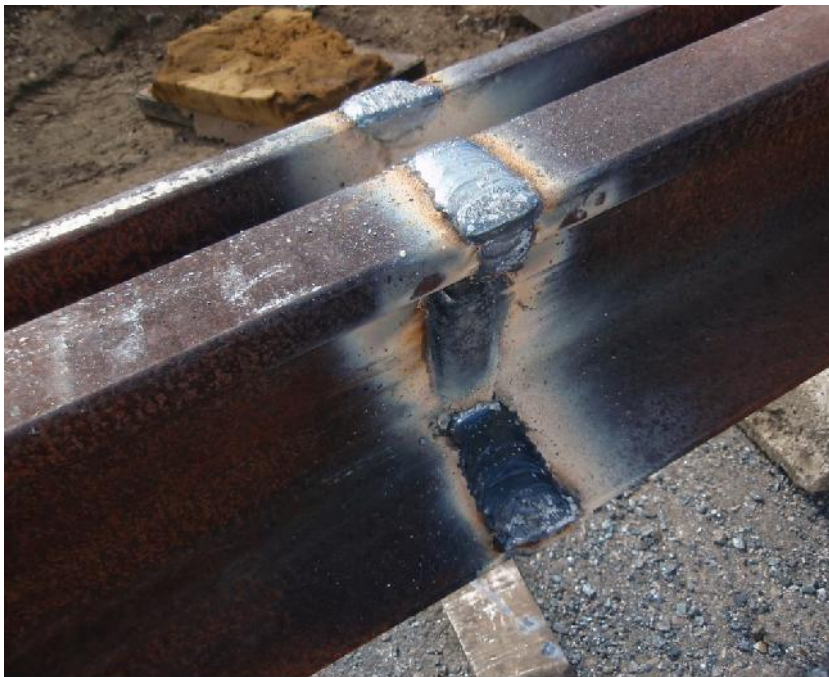
Slika 4.7. Konačni izgled zavara tračnice prije brušenja
