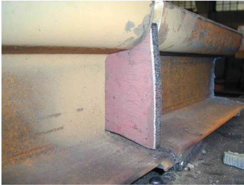
Slika 4.1. Postavljena specijalna umetna ploča nakon zavarivanja nožice tračnice [20]
