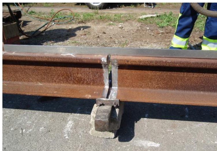
Slika 4.4. Mjerenje kuta predeformacije tra nica pomo u ravnala
