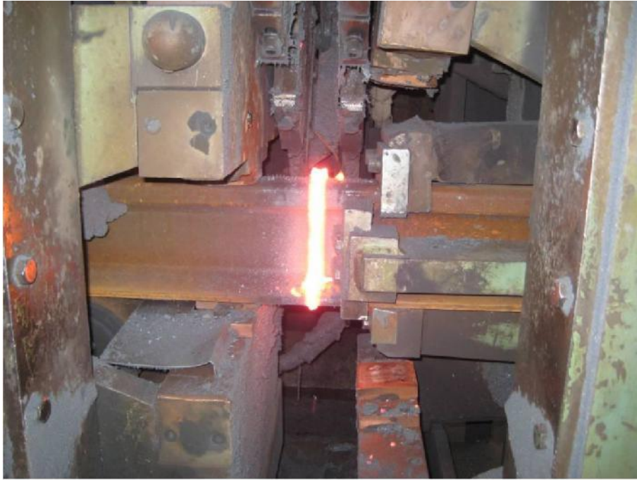
Slika 3.3. Zavarivanje tra nica iskrenjem [9]
