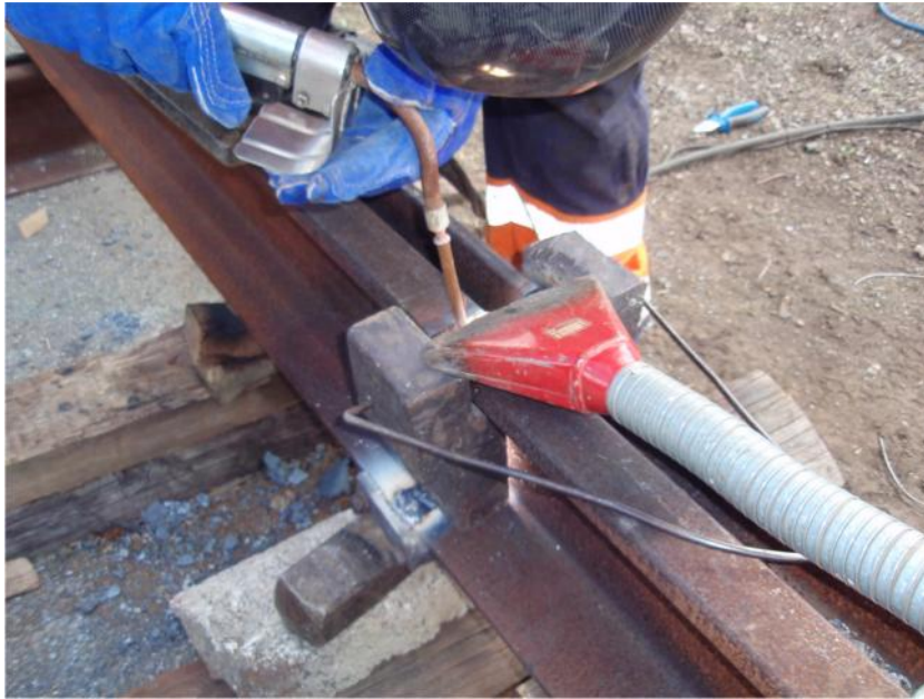
Slika 4.6. Zavarivanje vrata tra nice uz uporabu bakrenih obloga
