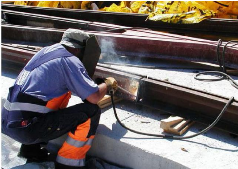
Slika 3.7. Zavarivanje žljebaste tračnice REL postupkom uz upotrebu čelične ploče [17]
