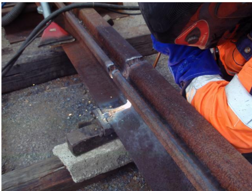
Slika 4.5. Zavarivanje nožice tra nice
