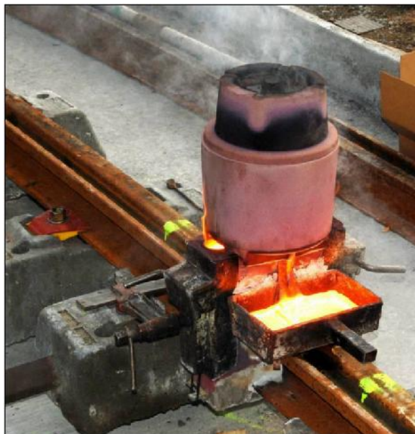
Slika 3.5. Zavarivanje tra nica aluminotermijskim postupkom [9]
