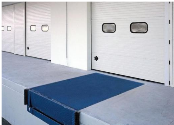
Slika 2. Pretovarna platforma
