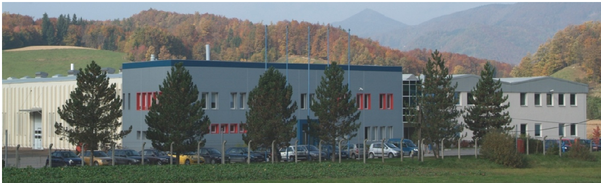
Slika 2. Upravna zgrada i dio pogona OMCO Croatia d.o.o.[5]
