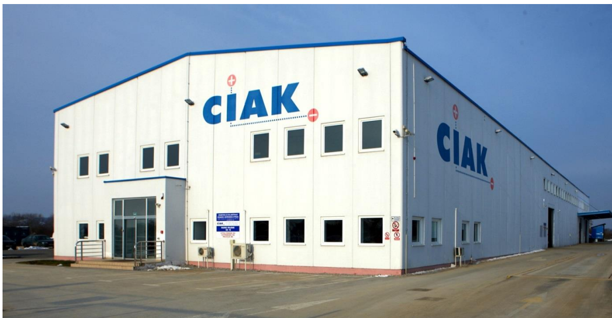
Slika 28 Skladište opasnog otpada Zabok
