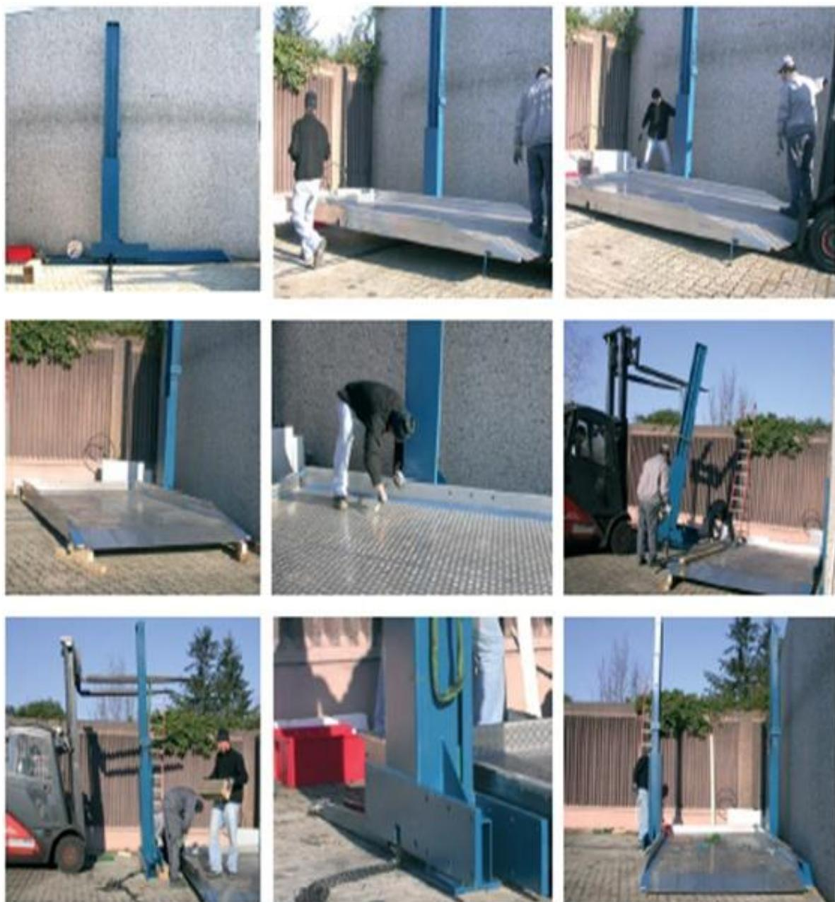
Slika 38. Montaža jednostrukog uređaja parkiranja
