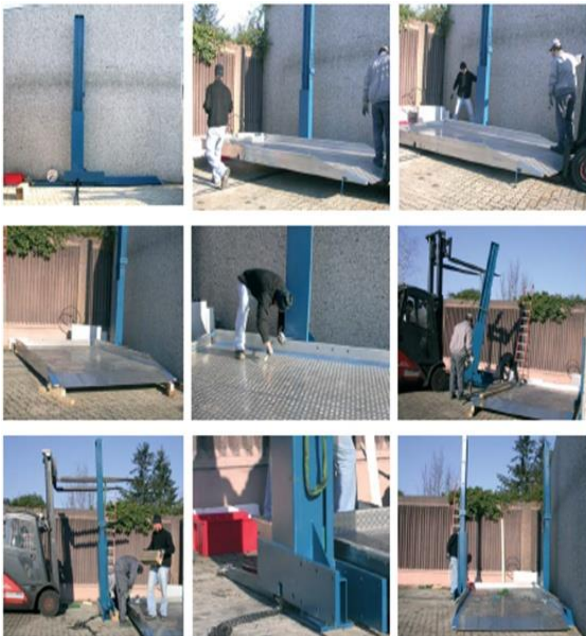
Slika 38. Montaža jednostrukog uređaja parkiranja
