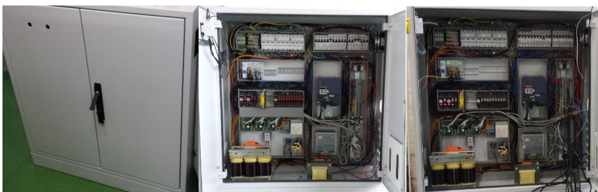
Slika 5.2 Elektro-ormar u različitim fazama izrade
