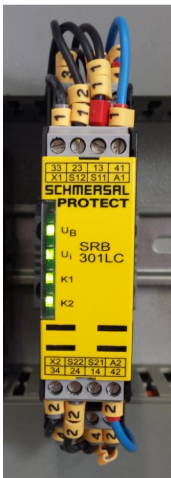
Slika 4.18 Sigurnosni relej u aktiviranom stanju
