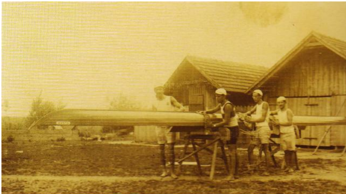
Slika 3. Klinker četverac s preklopnom građom[2]
