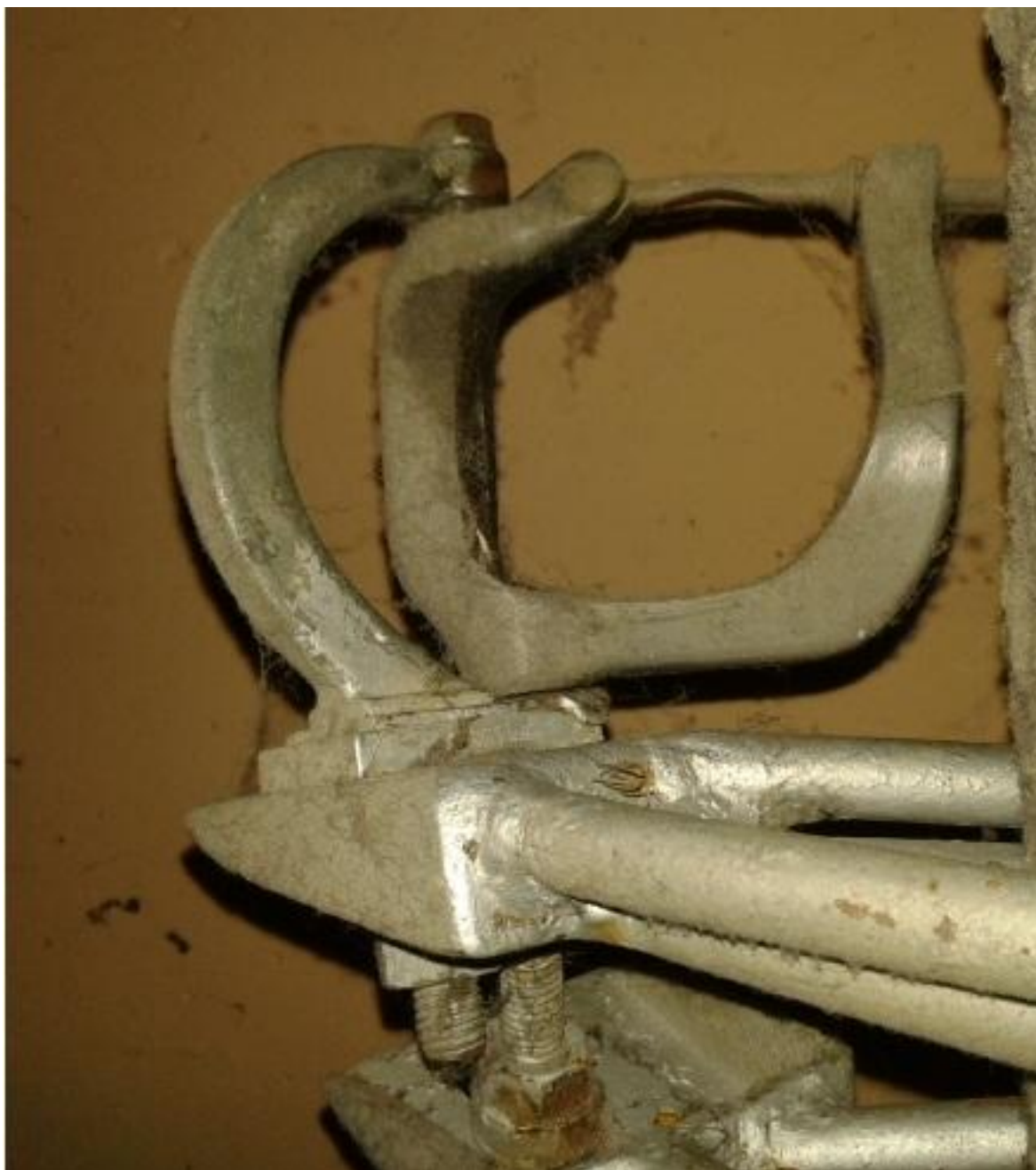
Slika 11. Čelični izbočnik sa čeličnim lukom kao ukrotom protiv iskrivljenja osovine ušice
