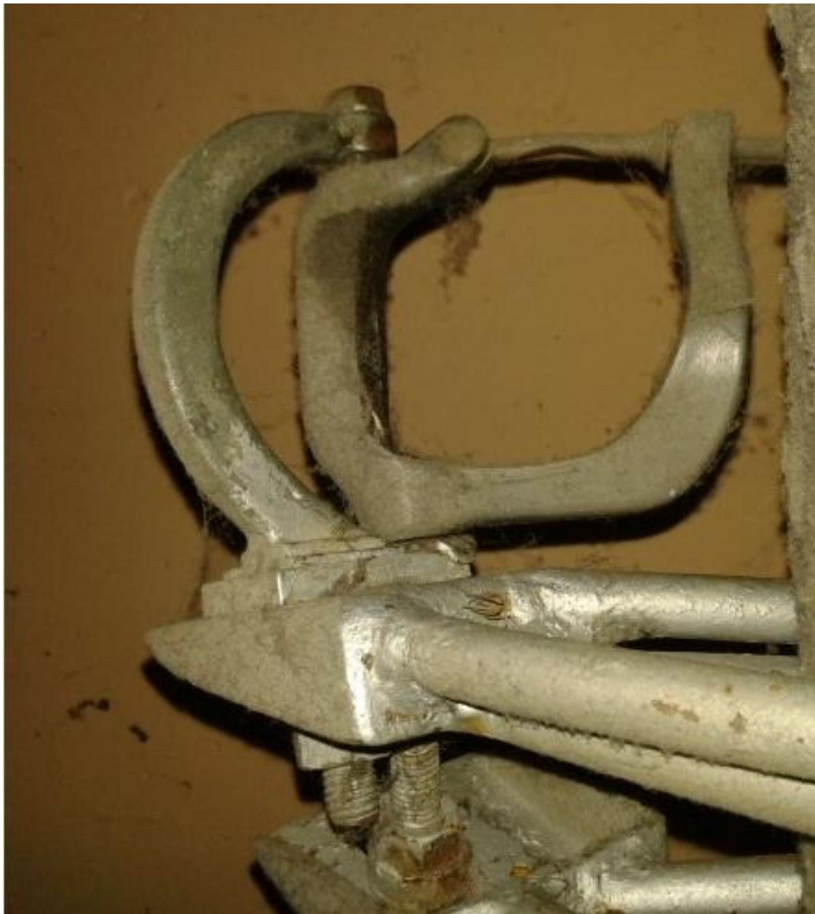
Slika 11. Čelični izbočnik sa čeličnim lukom kao ukrutom protiv iskrivljenja osovine ušice
