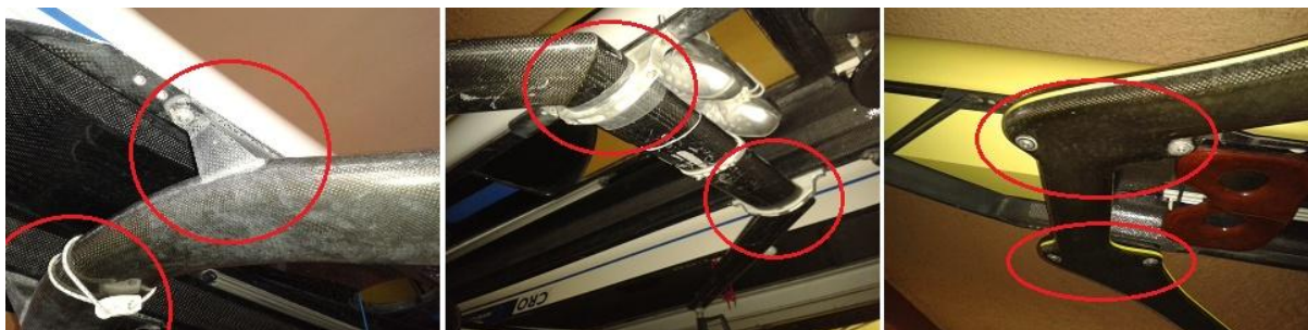
Slika 16. Mjesta spajanja ugljičnih krila i trupa: nosači od ugljičnih vlakana (lijevo), aluminijski nosači (sredina), direktan spoj izbočnika i trupa čamca (desno)
