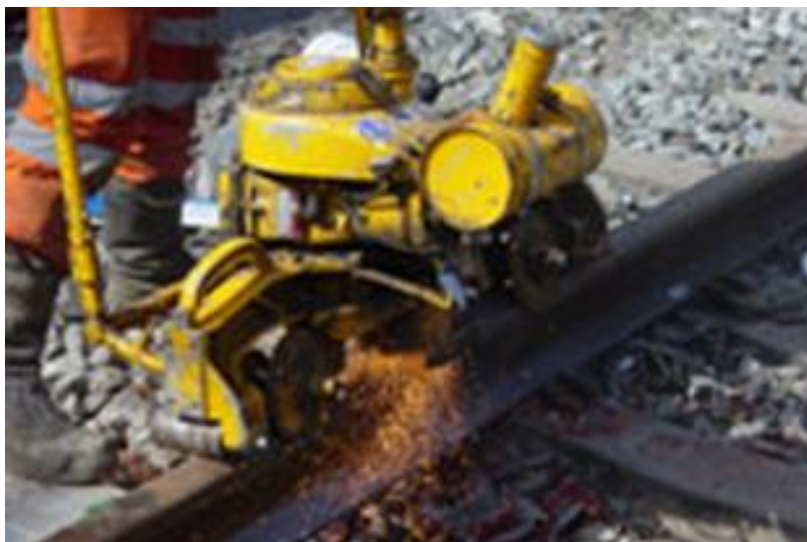
Slika 33 Završno brušenje tračnica [4]
