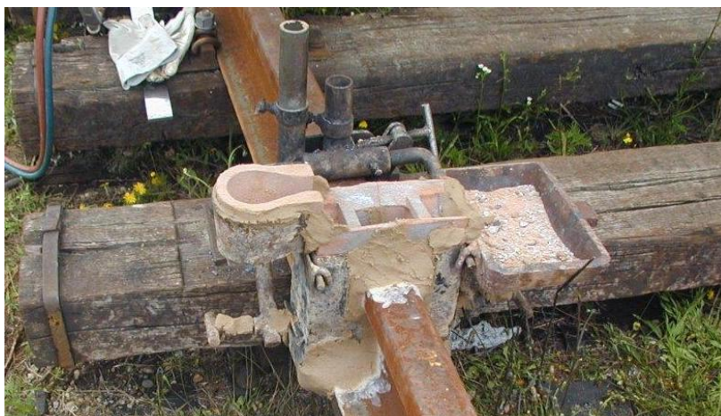
Slika 26 Postavljanje kalupa na mjesto spoja
