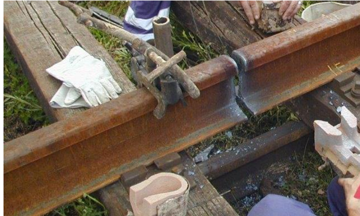
Slika 25 Priprema spoja i položaj tračnica prije zavarivanja [16]
