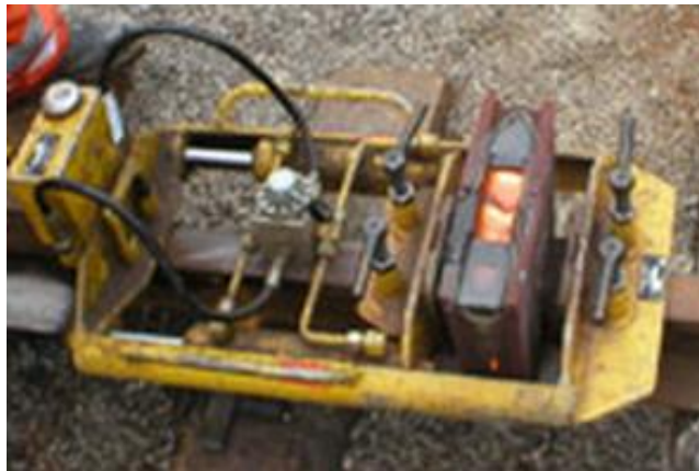
Slika 32 Hidrauličko uklanjanje kalupa i viška materijala [4]
