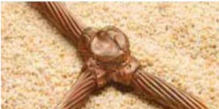
Slika 24 Zavarivanje bakrenih vodiča [18]
